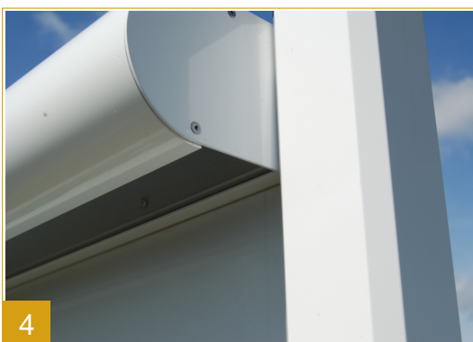
4 Detalje af enkltsidet lysprofil med LED-lys, hvidlakeret. Lysprofiler leveres også i dobbeltsidet udgave. De er tilpasset til alle typer af standerben.
